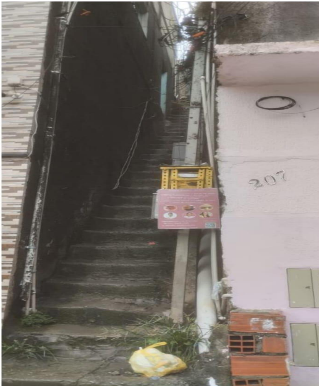
Rua João Francisco Lisboa n. 207. Vielas 10 - Escadão do Jó.
