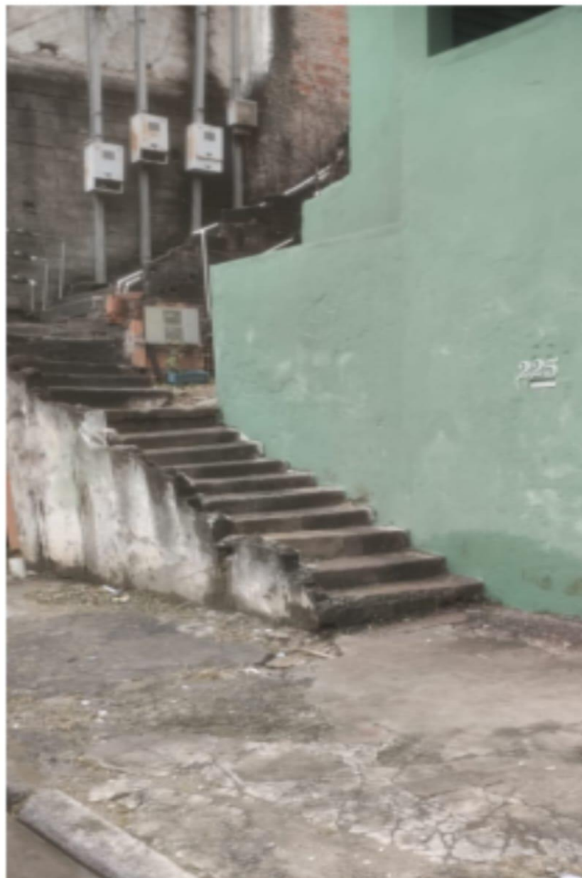
Rua João Francisco Lisboa n. 225 Vielas 09 - Escadão da Dona Meyre
