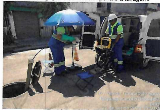
Imagem 04 – Equipes realizando diagnóstico técnico.
