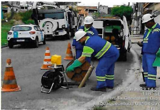
Imagem 05 – Equipes realizando diagnóstico técnico.
