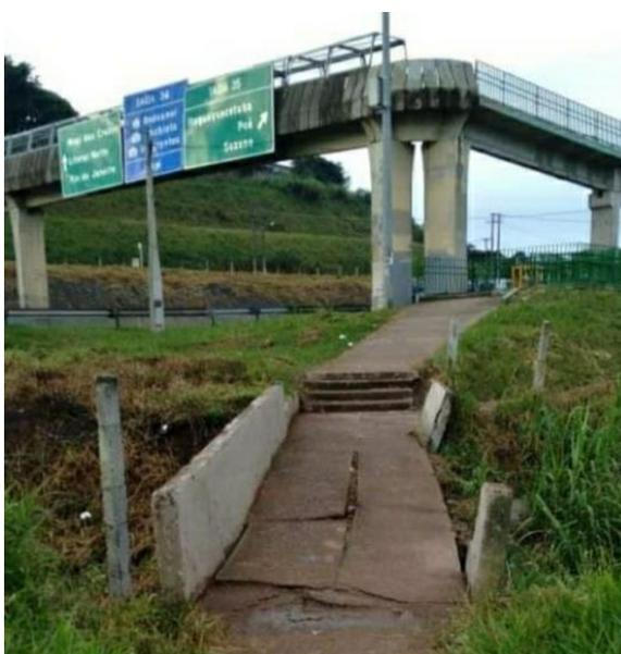
Note na foto acima que as placas estão quebradas e desniveladas, e sem apoio lateral.
