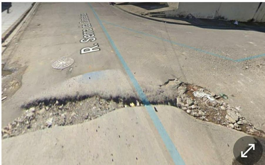
Sem o Sarjetão a força da água das chuvas leva o asfalto deixando grandes buracos na via
