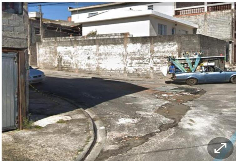
Sem o Sarjetão a força da água das chuvas leva o asfalto deixando grandes buracos na via
