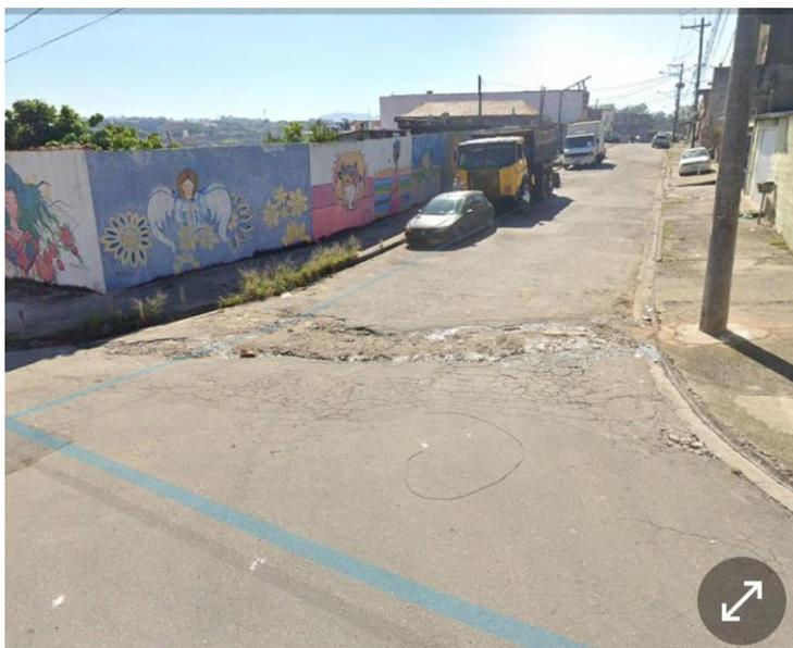
Sem o Sarjetão a força da água das chuvas leva o asfalto deixando grandes buracos na via
