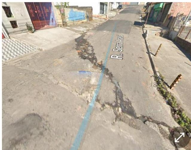
Sem o Sarjetão a força da água das chuvas leva o asfalto deixando grandes buracos na via
