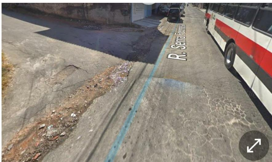
Sem o Sarjetão a força da água das chuvas leva o asfalto deixando grandes buracos na via
