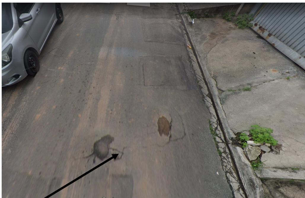
Obs. Crateras com afundamento de quase 0,30cm na superfície da pavimentação.
