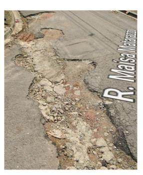
Sem o Sarjetão a força da água das chuvas leva o asfalto deixando grandes buracos na via
