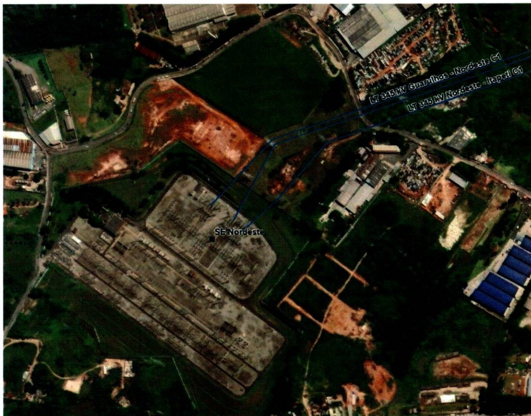
Figura 1 - Subestação Nordeste-SP (fonte: MME).
