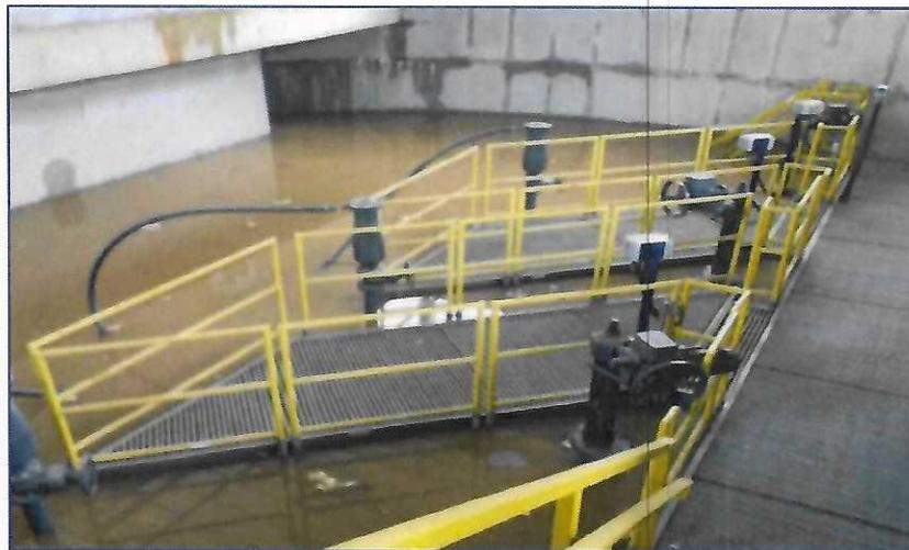
Figura 6 – Vista interna da elevatória inundada em 12/03/2023
