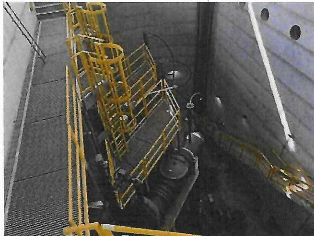
Figura 8 – Visão do poço de sucção e barrilhete de recalque da elevatória
