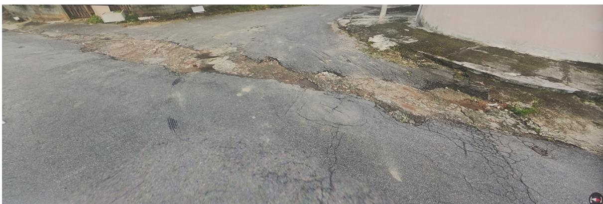
Sem o Sarjetão a força da água das chuvas leva o asfalto deixando grandes buracos na via
